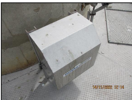
ภาพที่ 2.4 ระบบ Continuous Emission Monitoring (CEMs) หม้อเผาปูนซีเมนต์ขาว 2
