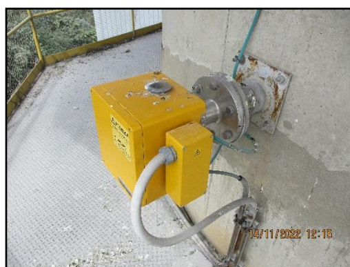
ภาพที่ 2.3 ระบบ Continuous Emission Monitoring (CEMs) หม้อเผาปูนซีเมนต์ขาว 1
