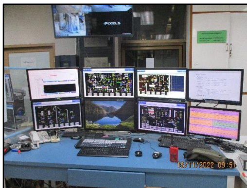
ภาพที่ 2.4 ระบบ Continuous Emission Monitoring (CEMs) หม้อเผาปูนซีเมนต์ขาว 2
