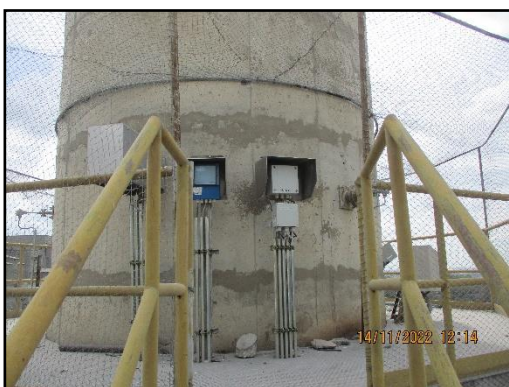
ภาพที่ 2.3 ระบบ Continuous Emission Monitoring (CEMs) หม้อเผาปูนซีเมนต์ขาว 1
