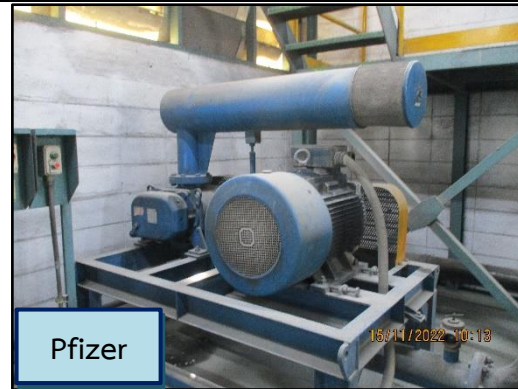
ภาพที่ 2.20 (ต่อ) ห้องเก็บเสียงของ Blower และ Pfizer สำหรับป้องกันเสียงจากกระบวนการผลิต
