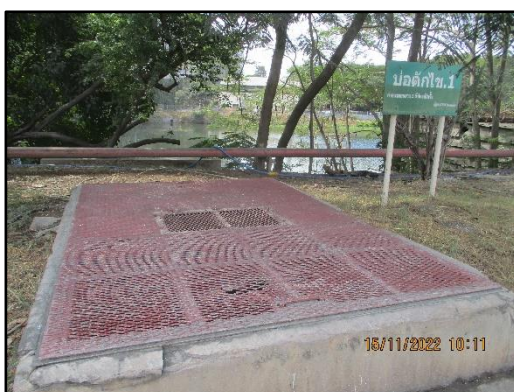
ภาพที่ 2.16 ระบบบำบัดน้ำเสียแบบบ่อเกรอะ-บ่อซึม สำหรับบำบัดน้ำเสียที่มาจากห้องส้วม
